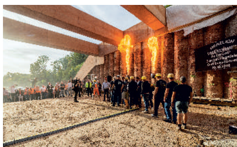
Průchod razičské osádky portálovou stěnou doprovázely ohnivé efekty.
