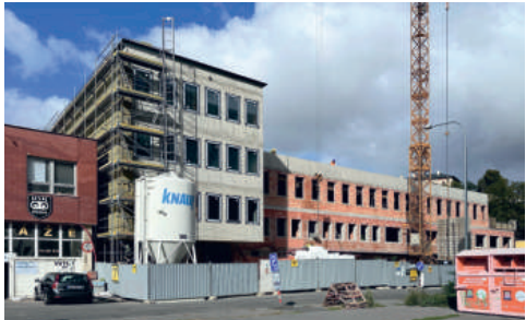
Dokončením hrubé stavby získalo sportovní centrum svoji novou siluetu.
