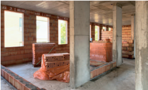
Uvnitř nástavby pokračují práce na keramických vyzdívkách příček.
