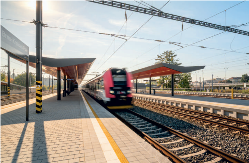
Královopolské nádraží, které je druhou nejvytíženější železniční stanicí v Brně, získalo po více než sedmdesáti letech zcela novou, moderní podobu.
