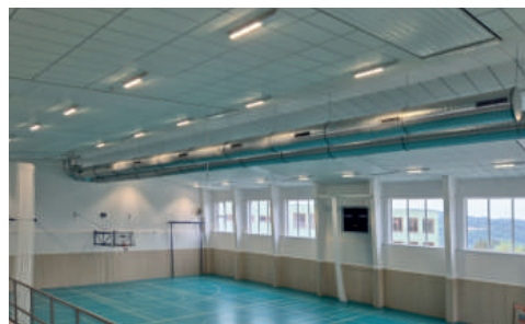
Součástí zakázky bylo i technické vybavení tělocvičny, nové části školního areálu.
