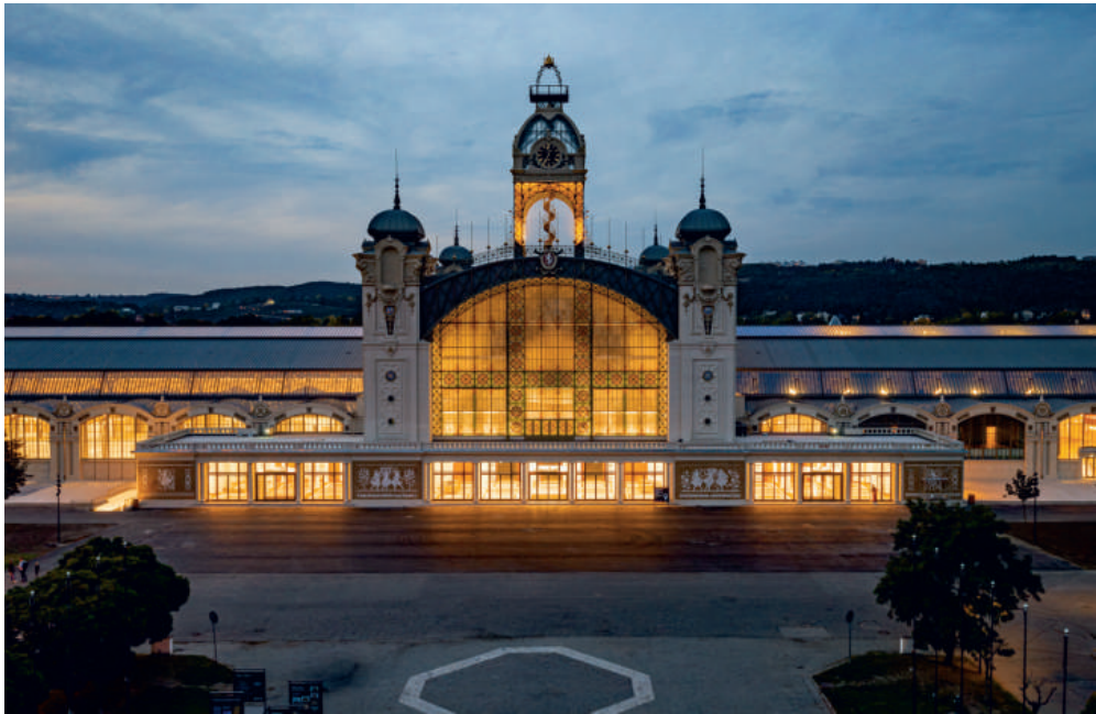
Průmyslový palác má opět symetrické průčelí. Zatímco střední část a pravé křídlo prošly celkovou renovací, křídlo levé bylo znovu postaveno.
