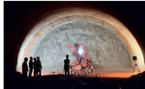
Prorážka tunelu Opevnění přinesla obvyklé působivé momenty.
