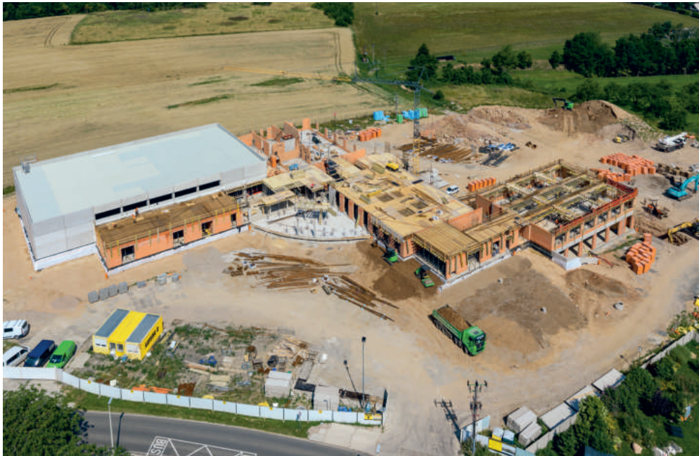
Po necelém roce výstavby získala doubravčická škola hrubé obrysy. Tělocvičnu z prefabrikovaného železobetonu postupně doplňují zděné objekty s monolitickými stropy.
