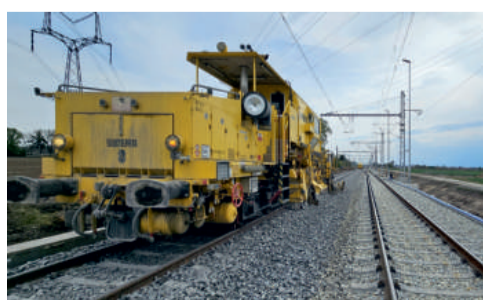
Realizaci železničního svršku završují úpravy kolejového lože.
