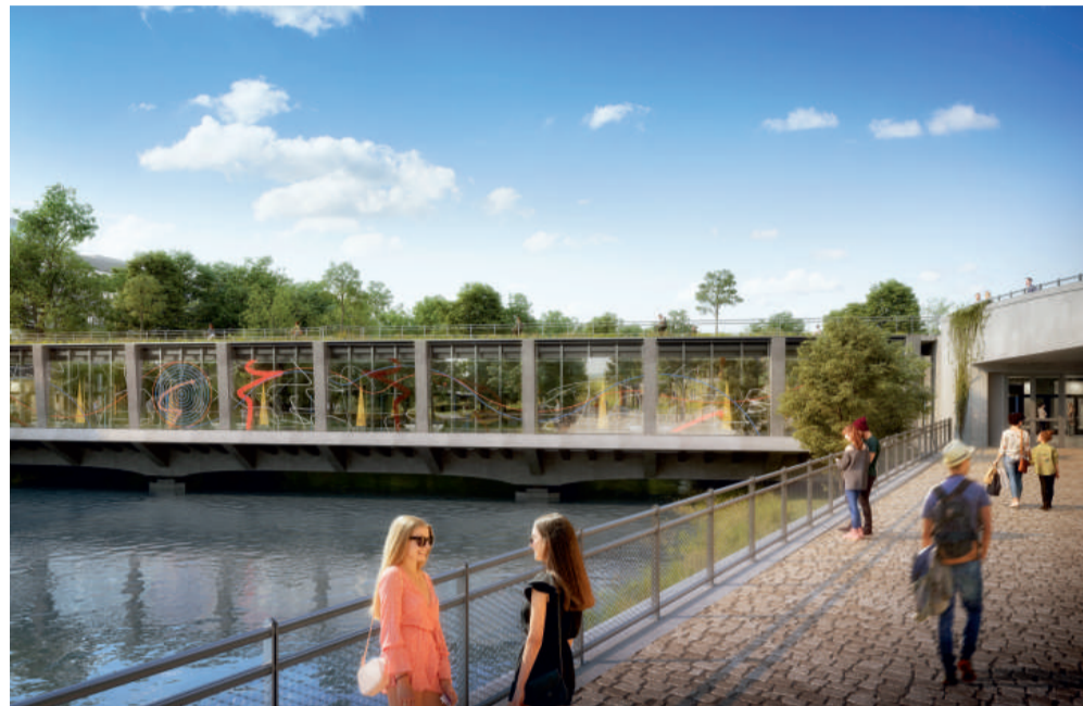
Nadzemní stanice Nádraží Krč bude mít podobu proskleného mostu přes vodní plochu, jehož střecha bude pochozí. Prostory metra se propojí s okolním parkem a další výstavbou.
