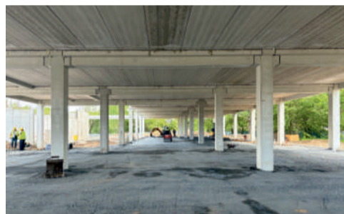
Depozitní část tvoří montovaný železobetonový skelet, realizace tedy postupuje rychle.
