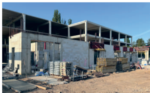
Stavba administrativní části kombinuje monolitické a zděné konstrukce.
