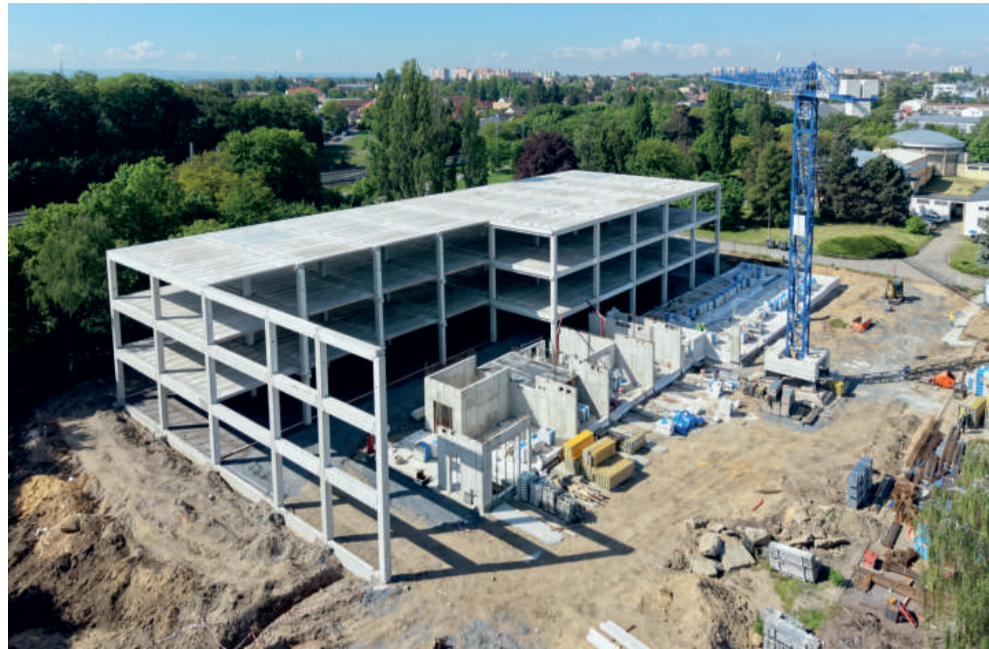
Budova depozitáře v Horních Počernicích již získává základní obrysy. Objekt budou tvořit dvě propojené hmoty, větší depozitní a menší administrativní.
