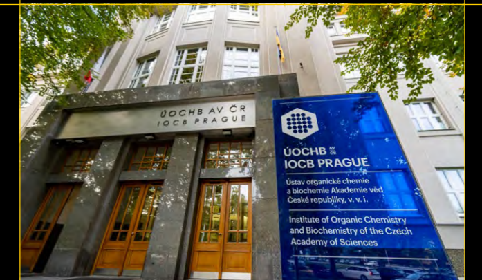
VÝSTAVBA PODZEMNÍCH LABORATORÍ ÚOCHB, PRAHA CONSTRUCTION OF THE UNDERGROUND LABORATORY OF THE INSTITUTE OF ORGANIC CHEMISTRY AND BIOCHEMISTRY, PRAGUE
