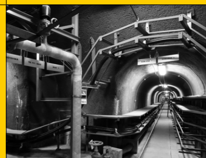
KOLEKTOR NÁMĚSTÍ SVOBODY, BRNO NÁMĚSTÍ SVOBODY UNDERGROUND UTILITY TUNNEL, BRNO
