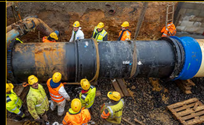
PŘELOŽKA VODOVODU PŘI VÝSTAVBĚ TRAMVAJOVÉ TRATI DIVOKÁ ŠÁRKA - DĚDINA RELOCATION OF WATER MAIN DURING CONSTRUCTION OF THE DIVOKÁ ŠÁRKA - DĚDINA TRAM LINE
