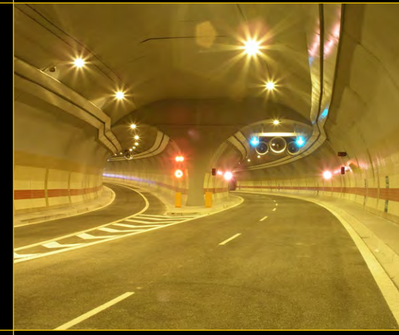
1998 TUNEL MRÁZOVKA V PRAZE 1998 MRÁZOVKA TUNNEL IN PRAGUE
