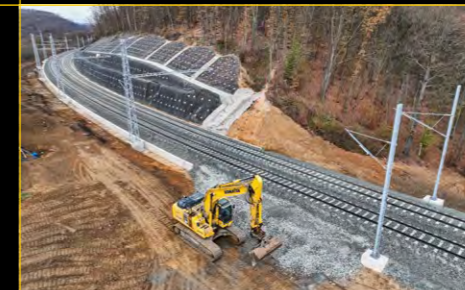
ELEKTRIZACE ŽELEZNIČNÍ TRATI STRELICE - ZASTÁVKA U BRNA ELECTRIFICATION OF THE STRELICE - ZASTÁVKA U BRNA RAILWAY LINE
