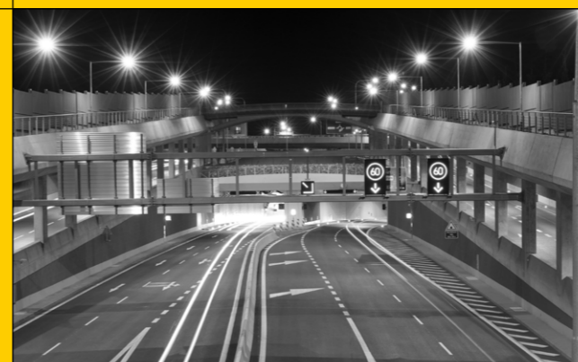
KRÁLOVOPOLSKÝ TUNEL NA VMD BRNO KRÁLOVO POLE TUNNEL ON THE GREAT RING ROAD, BRNO
