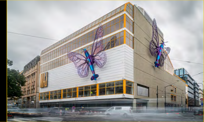
TZB PŘI REKONSTRUKCI OBCHODNÍHO DOMU MAJ, PRAHA SERVICE SYSTEMS FOR THE RECONSTRUCTION OF THE MAJ DEPARTMENT STORE, PRAQUE
