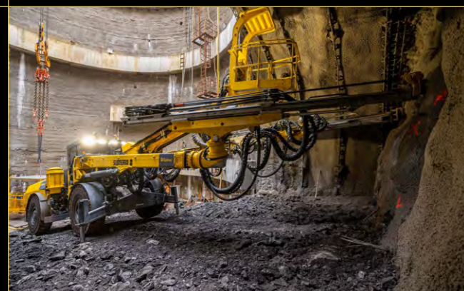
ZAHÁJENÍ RAŽEB PŘÍSTUPOVÉ A VZDUCHOTECHNICKÉ STOLY 06/2022 START OF MINING OPERATIONS OF THE ACCESS AND VENTILATION TUNNEL IN 06/2022
