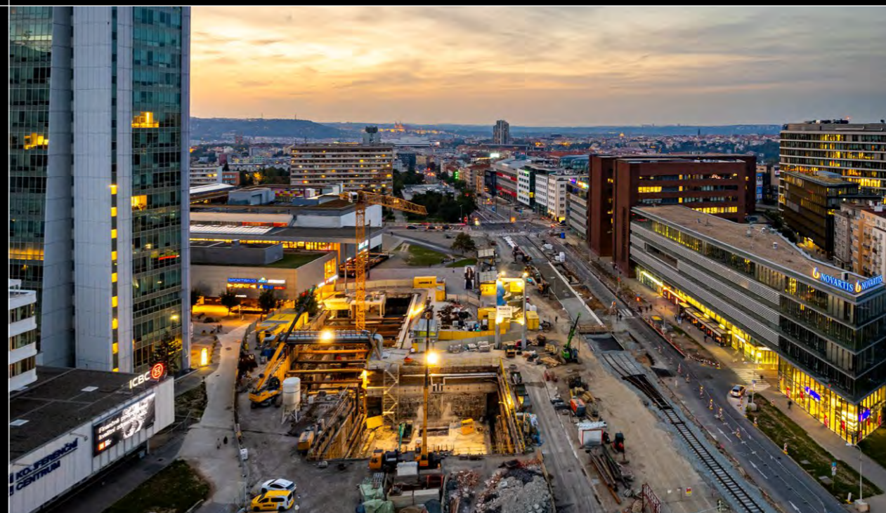
STAVEBNÍ JÁMY VESTIBULU ARKÁDY A PŘESTUPU MEZI LINKAMI C A D – 09/2024 CONSTRUCTION PIT OF THE ARCADE VESTIBULE AND PIT OF TRANSFER CORRIDOR BETWEEN LINE C AND D
