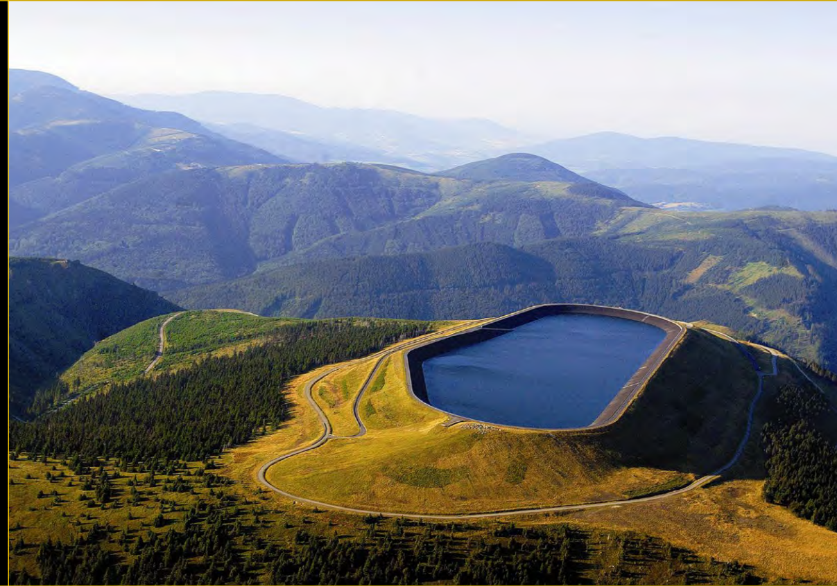
1978 PŘEČERPÁVACÍ VODNÍ ELEKTRÁRNA DLOUHÉ STRANĚ 1978 DLOUHÉ STRANĚ PUMPED STORAGE HYDROELECTRIC POWER PLANT
