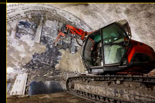
PRORÁŽKA ESKALÁTOROVÉHO TUNELU GEMINI SKRZE PAŽENÍ STAVEBNÍ JÁMY DO SUTERÉNNÍCH PROSTOR OBJEKTU GEMINI GEMINI ESCALATOR TUNNEL - BREAKTHROUGH THROUGH OLD PIT CONSTRUCTION LINING TO UNDERGROUND SPACES IN GEMINI BUILDING
