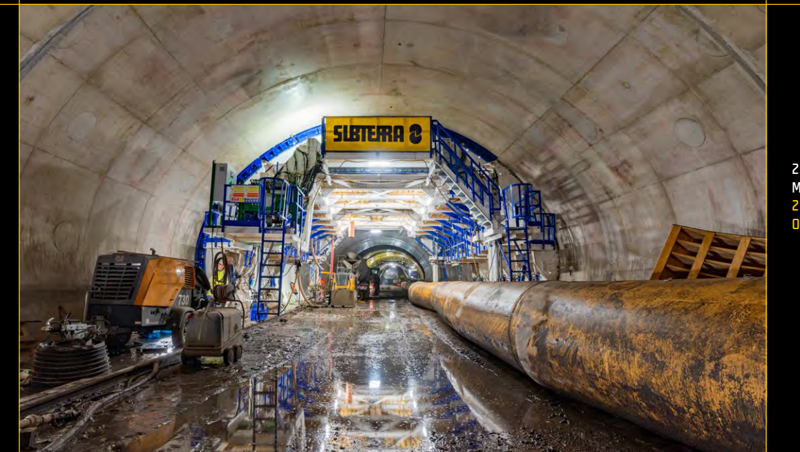
2022 ZAHÁJENÍ VÝSTAVBY METRA D 2022 START OF CONSTRUCTION OF METRO D
