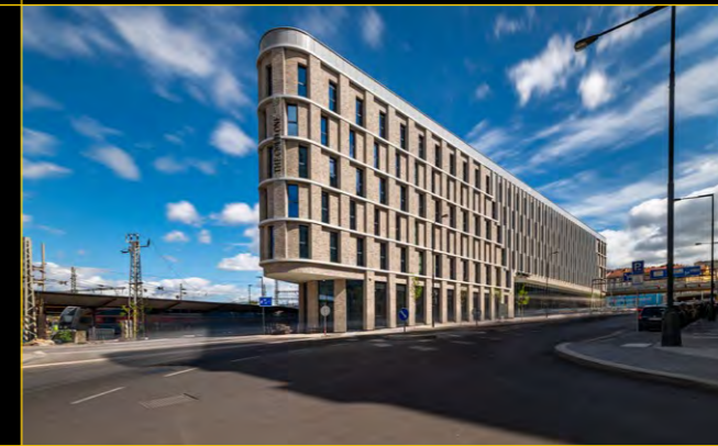
TZB PŘI VÝSTAVBĚ HOTELU THE CLOUD ONE, PRAHA SERVICE SYSTEMS FOR THE CLOUD ONE HOTEL, PRAQUE
