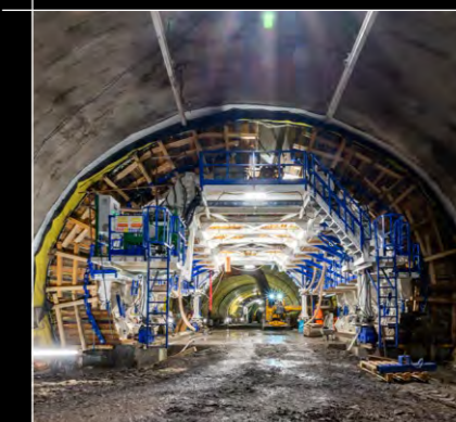
BEDNÍČÍ VŮZ KLENBY SEKUNDÁRNÍHO OSTĚNÍ OBRATOVÉHO TUNELU – 12/2024 VAULT TRAVELLER FORMWORK OF SECONDARY LINING – THE TUNNEL FOR TURN-BACK TRACKS – 12/2024
