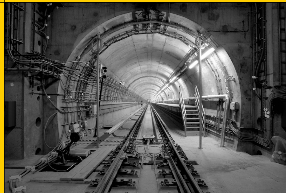
PRAŽSKÉ METRO – TRASA A, ÚSEK DEJVICKÁ–MOTOL DEJVICKÁ–MOTOL SECTION OF PRAGUE METRO LINE A
