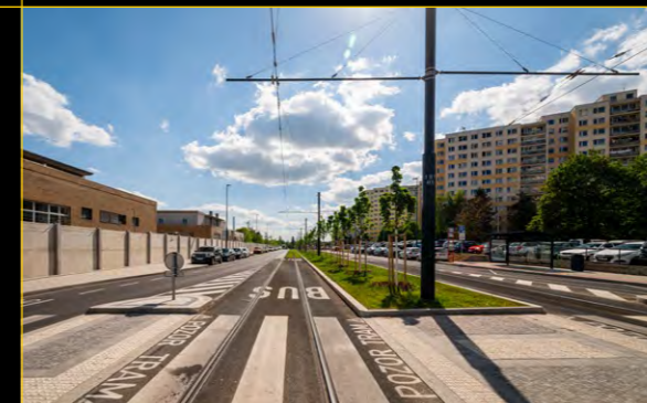
VÝSTAVBA TRAMVAJOVÉ TRATI DIVOKÁ ŠÁRKA - DĚDINA, PRAHA CONSTRUCTION OF THE DIVOKÁ ŠÁRKA - DĚDINA TRAM LINE IN PRAGUE
