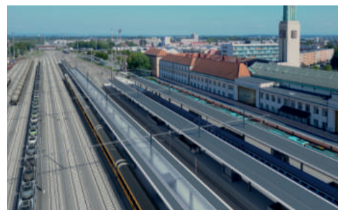
Významnou součástí modernizace bude výstavba třetího ostrovního nástupiště.
