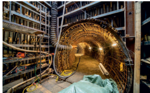
Ražená stoka, která propojí šachty BD1 a BD2, bude mít délku téměř 117 metrů.
