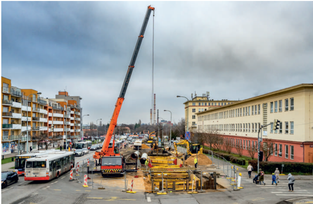
Rozsáhlé výkopové práce spojené s přeložkou inženýrských sítí v Počernické ulici v Malešicích přinášejí omezení veřejné i individuální dopravy.
