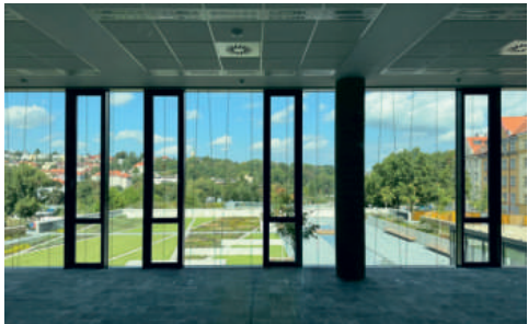
Plochá střecha nad portálem Strahovského tunelu má zahradní úpravu.
