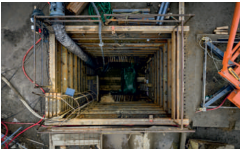
Šachta BD1 s hloubkou přesahující devět metrů bude po dokončení sloužit k revizím stoky.
