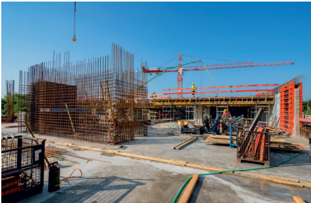
Konstrukce z monolitického železobetonu jsou z převážné části pohledové, což přináší vysoké nároky na přesné a vzhledově vyhovující provedení.
