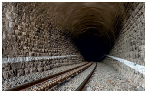
Dolnopolubenský tunel o délce 166 metrů má mimořádné stoupání 57 promile.
