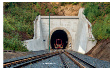
OPRAVA SEVEROČESKÝCH TUNELŮ
