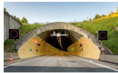
TECHNOLOGIE TUNELŮ NA D8
