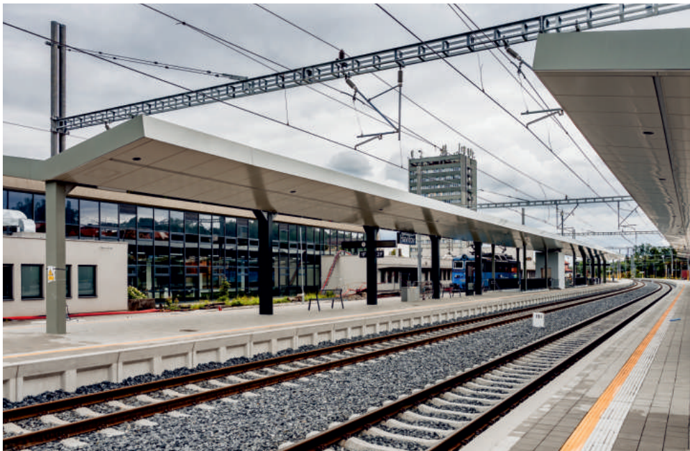
Vedle nových kolejí a drážního technologického vybavení zahrnuje rekonstrukce stanice Havířov dvě ostrovní nástupiště s bezbariérovým přístupem.
