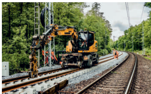
Mezi stroje využívané pro obnovu kolejí patřila i dvoucestná rýpadla.
