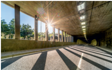
Pravý tubus tunelu Libouchec je o sto metrů delší než tubus levý a ukončuje jej galerie.
