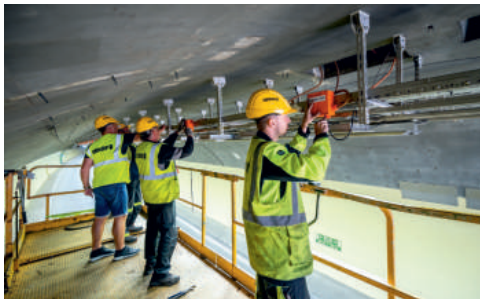
Zaměstnanci divize 4 v tunelech instalují také LED osvětlení.
