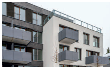
BYTOVÝ DŮM V PRAZE
