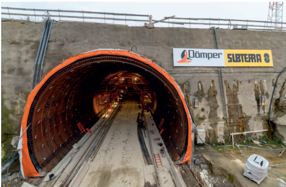
Výstavbu tunelu Bécsi domb v délce téměř osm set metrů zahájilo konsorcium SDD v říjnu 2020. Levý tubus byl proražen loni v červenci, práce na pravém pokračují.
