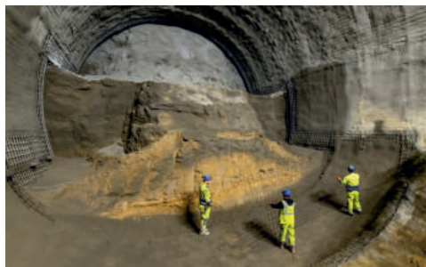
Primární ostění při ražbě NRTM je zpevňováno také pomocí kari sítí.
