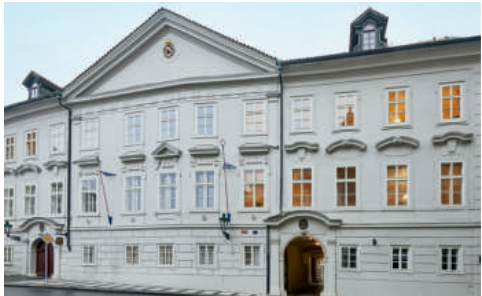
Součástí rekonstrukce bylo hlavní průčelí paláce na Valdštejském náměstí.
