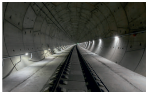
Ejrovický tunel poblíž Plzně razil Metrostav, pevnou jízdní dráhu pokládala Subterra.
