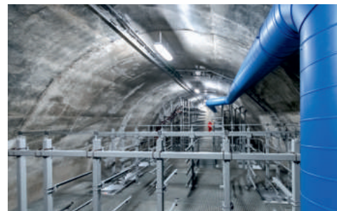
Kolektor Hlávkův most v Praze prochází pod dnem Vltavy a ostrovem Štvanice.
