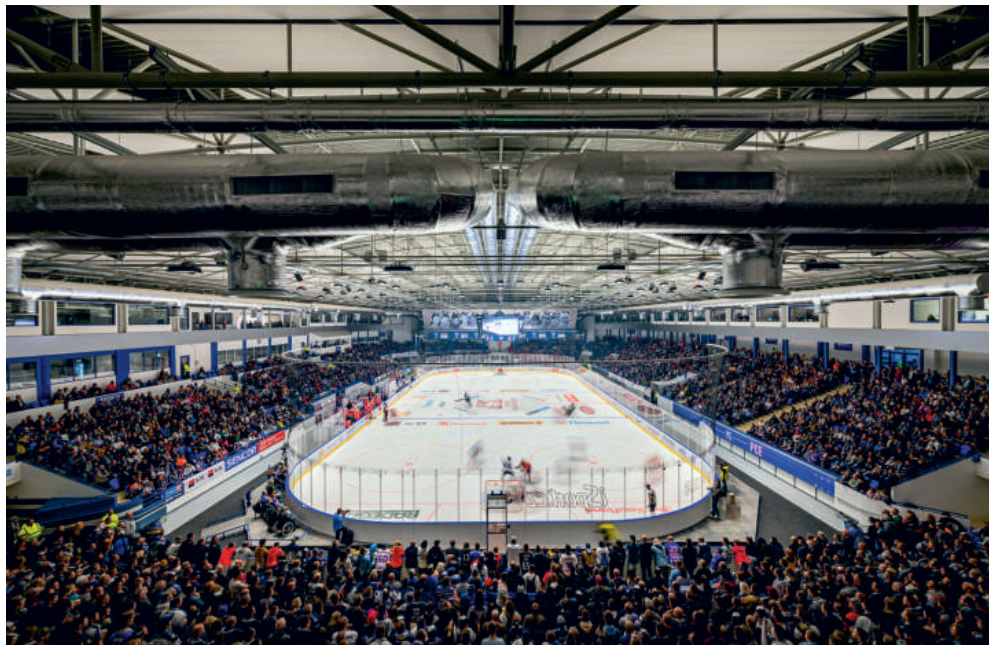
Hlavní prvky celkové rekonstrukce zimního stadionu v Kladně se nacházejí nad hlavami diváků. Nová ocelová střecha nese osvětlení, vzduchotechniku a další instalace.
