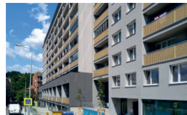
BYTOVÝ DŮM V PRAZE
