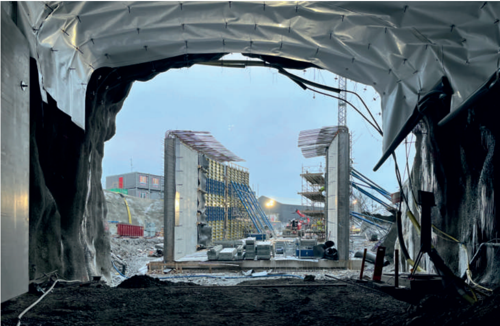
Rampové tunely pro autobusy navazující na hlavní tunel Skärholmen mají raženou i hloubenou část. Realizace monolitických konstrukcí vyžaduje předehřívání i chlazení betonu.
