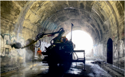
Při sanaci čtyř Blanenských tunelů využívá divize 1 novou kotoučovou pilu TEW-7.
