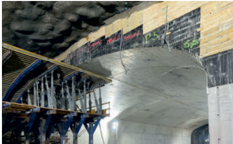
Tloušťka monolitického ostění pod jezerem Mälaren je mimořádná.
