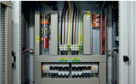
Rekonstrukce elektroinstalace samozřejmě zahrnuje i rozvaděče.
