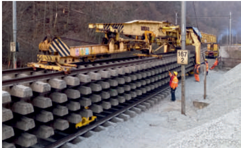
Podstatnou součástí projektu je rekonstrukce železničního svršku.
