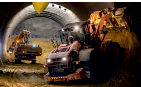
Oba tubusy tunelu Bécsi domb jsou nyní raženy zároveň.
