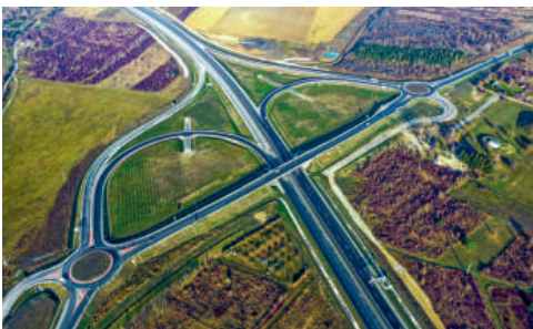
Součástí IV. etapy je také dopravní uzel v obci Balf, který se nachází nedaleko Šoproně.
