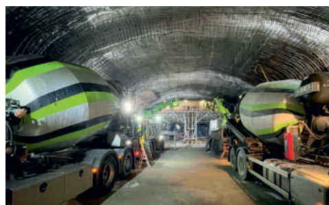
Práce na monolitickém ostění pod jezerem Mälaren pokračují druhým tubusem.
