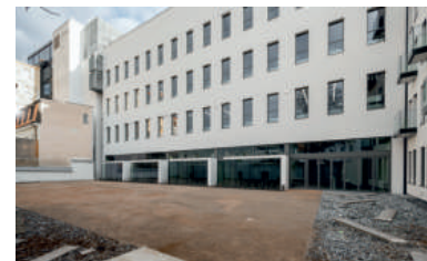
NOVÁ BUDOVA UMPRUM
