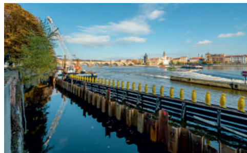
Zpřístupnění stěny pro stavební práce zajistí hráz z ocelových profilů, štětovic.
