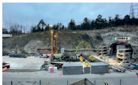
Rampy jsou betonovány postupně, každá na třech místech zároveň.
