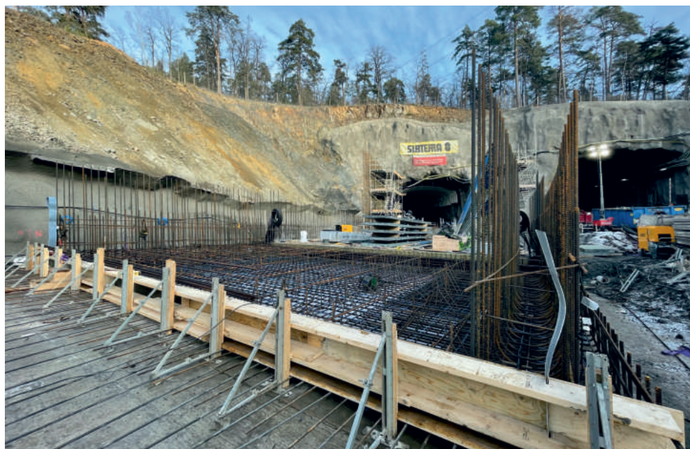
Rampy pro autobusy navazují na hlavní tunel Skärholmen v jihozápadní části švédské metropole. Realizace masivních monolitických konstrukcí vyžaduje předehřívání i chlazení betonové směsi.
