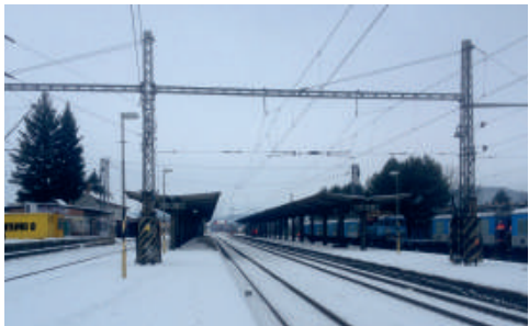
Práce ve stanici Kuřim zahájila Subterra nedlouho po začátku letošního roku.
