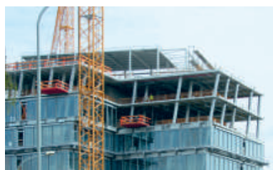
VÝSTAVBA CIIRC V DEJVICÍCH
