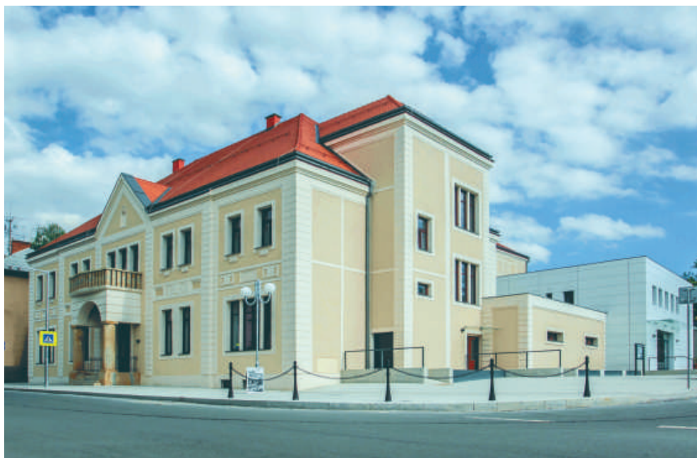
Příborský Kulturní dům znovu dostal reprezentativní podobu blízkou té původní z počátku 20. století. Okrovou fasádu dotváří mnoho dekoračních prvků, obnoven byl rovněž původní vstup v ose průčelí.
