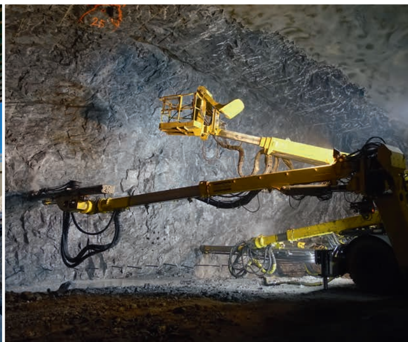
▼ Výstavba přístupových tunelů Skärholmen a Sättra, Švédsko / Construction of the Skärholmen and Sättra Access Tunnels, Sweden
