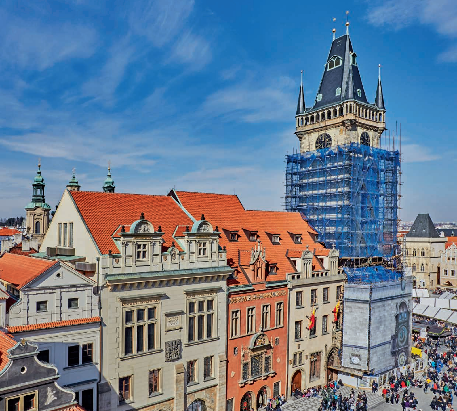
▲ Celková rekonstrukce věže Staroměstské radnice, Praha / Total reconstruction of the Prague Old Town Hall tower
