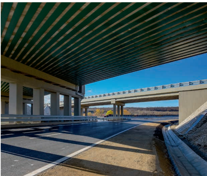
▼ Výstavba silničního obchvatu Várpalota, 2. etapa / Construction of the Várpalota road bypass, Stage 2
