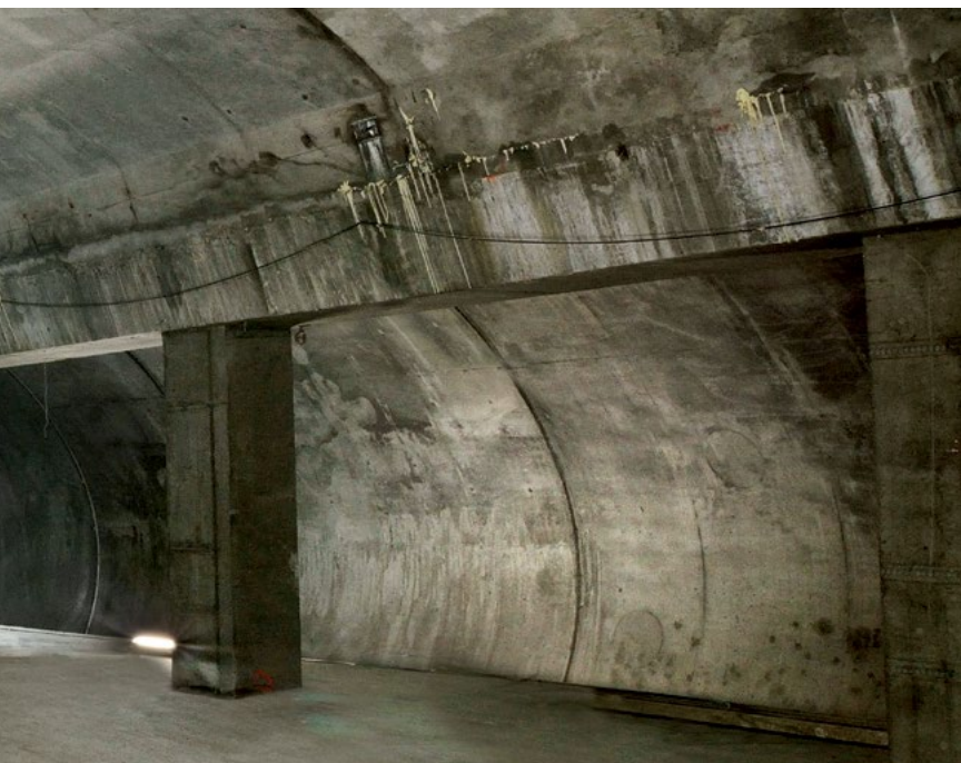
Výstavba trojlodní ražené stanice Nádraží Veveřslavín, Prodloužení metra VA (Dejvická-Motol), Praha
