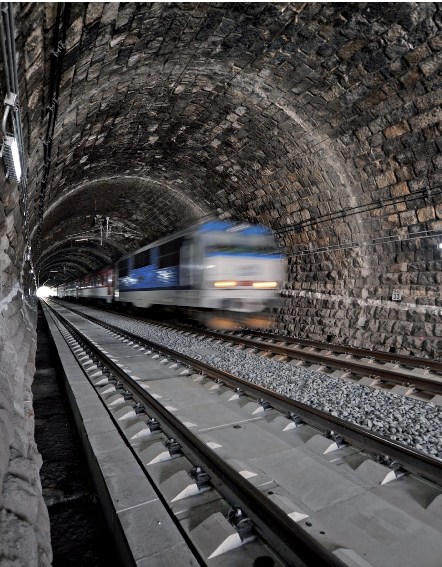
Rekonstrukce Střelenského tunelu na trati Horní Lideč–státní hranice SR Reconstruction of the Střelenský tunnel on the Horní Lideč–National border SR railway line
