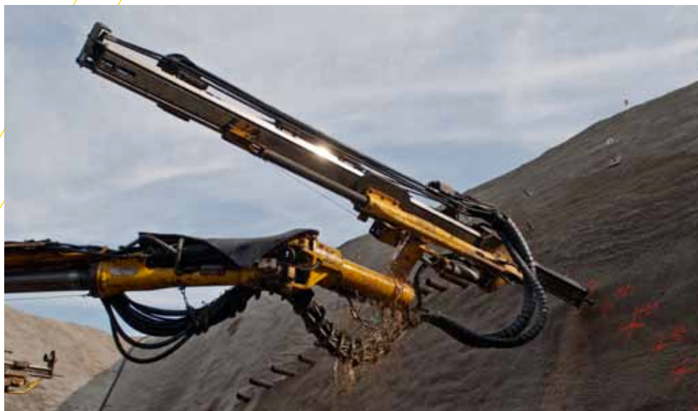
Instalace mikropilotového deštníku za pomoci vrtacího stroje Boomer L2C na výjezdovém portálu tunelu Tomice II. Installation of a micropile umbrella using the Boomer L2C drilling machine at the exit portal of the Tomice II tunnel.
