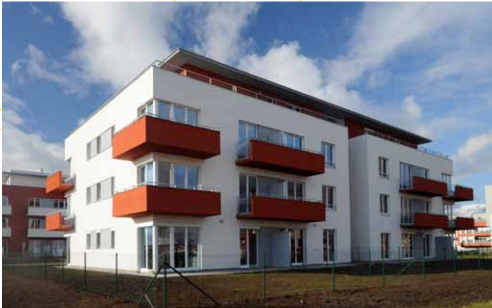
Bytové domy Pitkovice s celkem dvačtyřiceti bytovými jednotkami. Residential houses in Pitkovice with a total of 42 flats.
