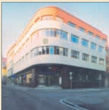
Rekonstruovaná budova České spořitelny, Kolín
