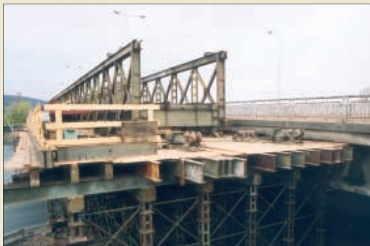
Provizorní most přes Berounku v Lahovicích
