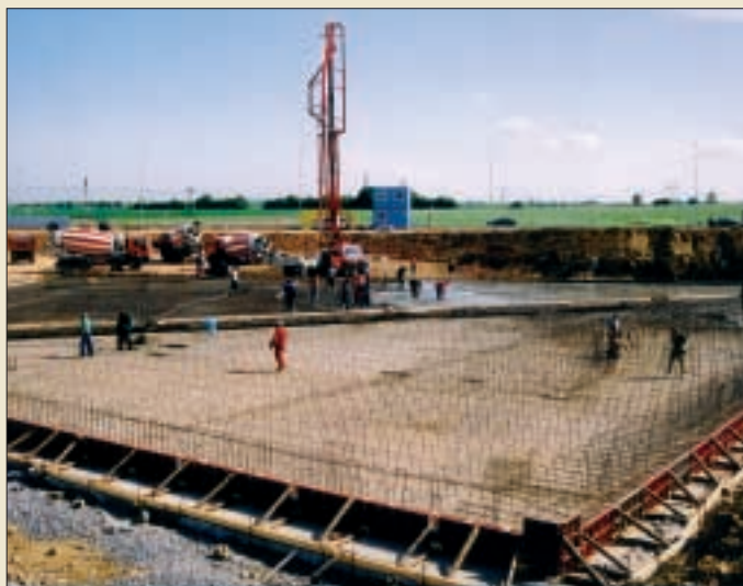
Poklepáním a posvěcením základního kamene byly zahájeny přípravné práce na stavbě Obchodního a zábavního centra v Praze Čestlicích.
