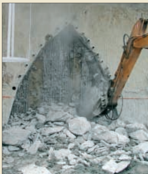
Silnice I/42 Brno, VMO Dobrovského A, práce na průzkumné štolě
