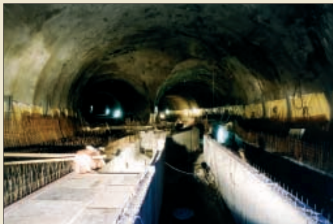
Betonáž mostovky rozpletu západní tunelové trouby tunelu Mrázovka, Praha
