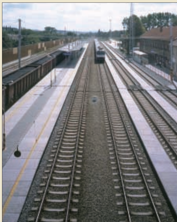
Stanice Tlumačov na II. železničním koridoru
