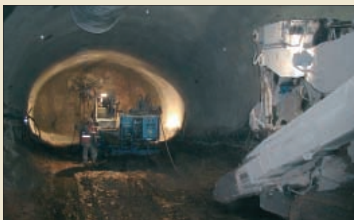
Čelba dvoukolejného traťového tunelu metra IV.C1 Praha - Trója
