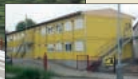
Zařízení staveniště stavby tramvajové trati
