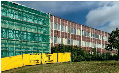
O době vzniku malešické polikliniky vypovídá charakteristická fasáda z boletických panelů.
