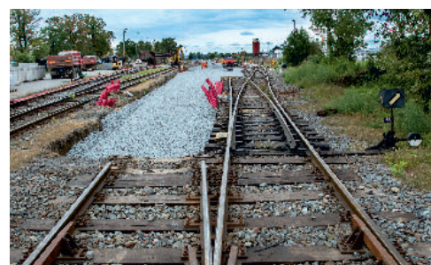
Divize 3 se na úpravách stanice Uničov zatím podílela snesením kolejových polí.
