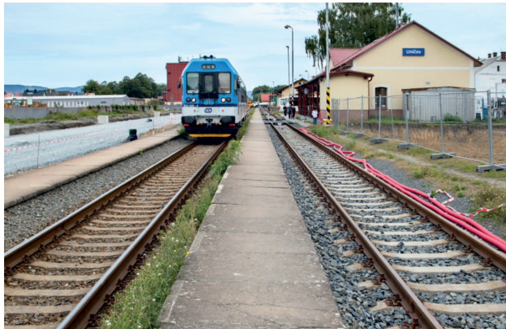
Stavební práce probíhají již od počátku srpna. Vzhledem k rekonstrukci kolejí, výhybek a mostů je přerušena vlaková doprava mezi Uničovem a Šternberkem.
