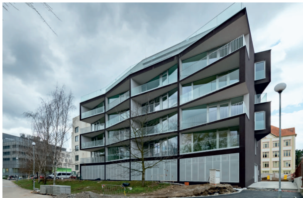
Bytový dům Corso je jednou ze staveb, které v Berouně podle návrhu společnosti ov architekti realizoval Metrostav a do nichž divize 4 instalovala technologie.
