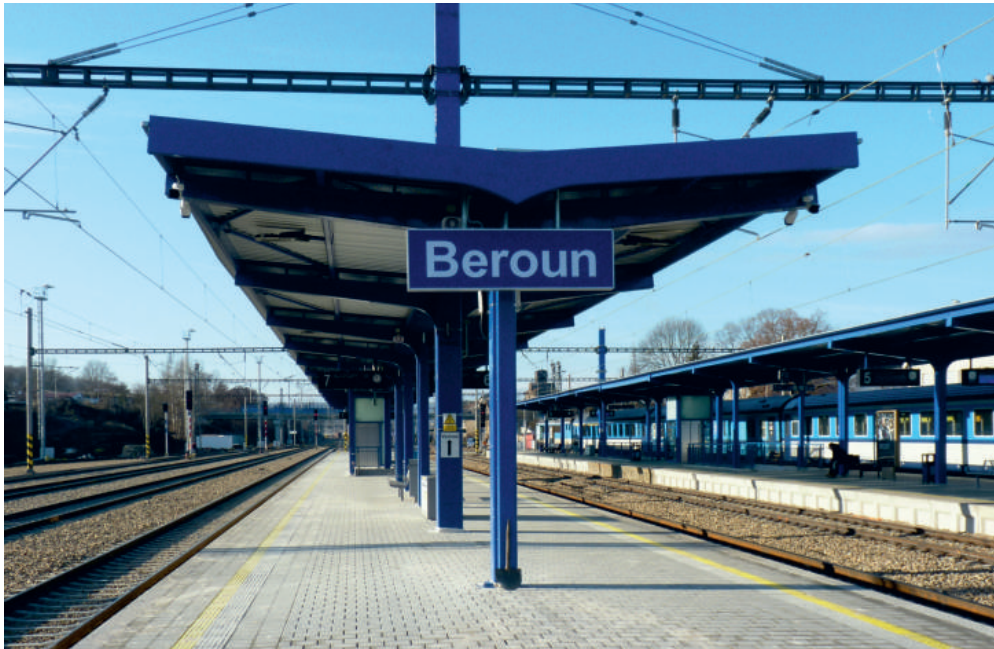
Cestující na berounském nádraží zaznamenají po dokončení projektu řadu změn. K nejviditelnějším patří nová, bezbariérově přístupná nástupiště včetně zastřešení a informačního systému.
