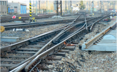
Výměna křižovatkové výhybky za jednoduchou byla poměrně složitá.
