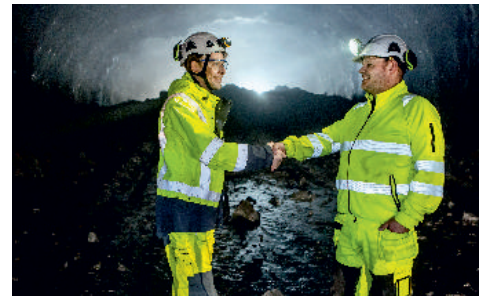
Zástupci obou ražebních čet se v podzemí poprvé setkali 20. března.
