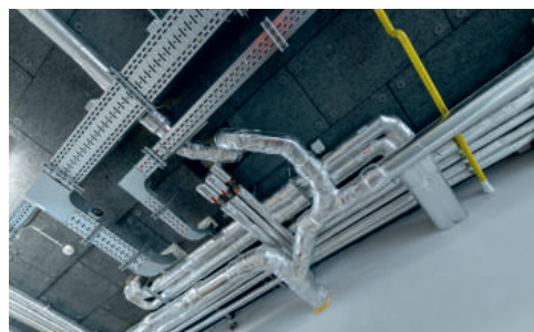
Divize 4 pro bytový dům dodávala veškeré technologie s výjimkou elektroinstalací.
