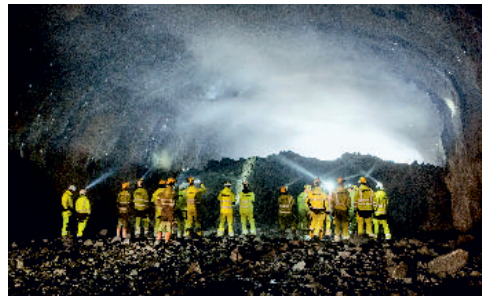
Propojení hlavního tunelu 202 výrazně usnadní dopravu na staveništi.
