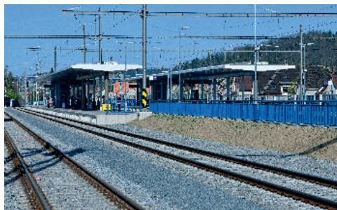
Nejviditelnější změnou na nádraží v Kuřimi jsou nová nástupiště.
