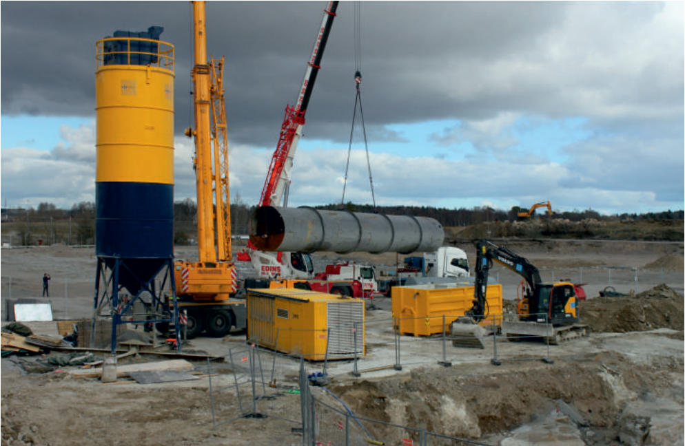
Ražby přístupového tunelu Veddesta byly zahájeny letos v červnu. Staveniště se nachází mimo osídlené oblasti Stockholmu, takže technika i další zařízení mají dostatek prostoru.
