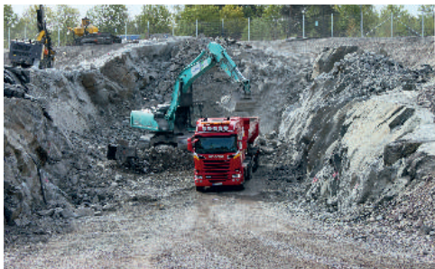
Kromě strojího rozpojování horniny byla při realizaci hloubené části tunelu využita trhavina.
