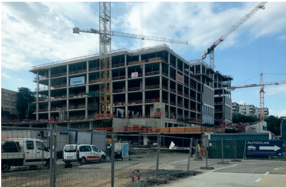
Soubor Churchill Square, kterým pokračuje zástavba nad hlavním nádražím, získává své obrysy. Administrativní budova D již dospěla do podoby kompletní hrubé stavby.
