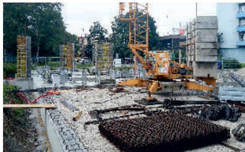
Vzhledem k omezeným rozměrům staveniště využívá divize 2 věžový jeřáb.
