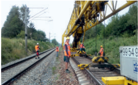
Divize 3 využívá vlastní mechanizaci. Ke snášení kolejového roštu slouží jeřáb PKP 25/20i.
