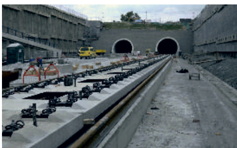
Na východním portálu přesahuje pevná jízdní dráha tunel o 165 metrů.
