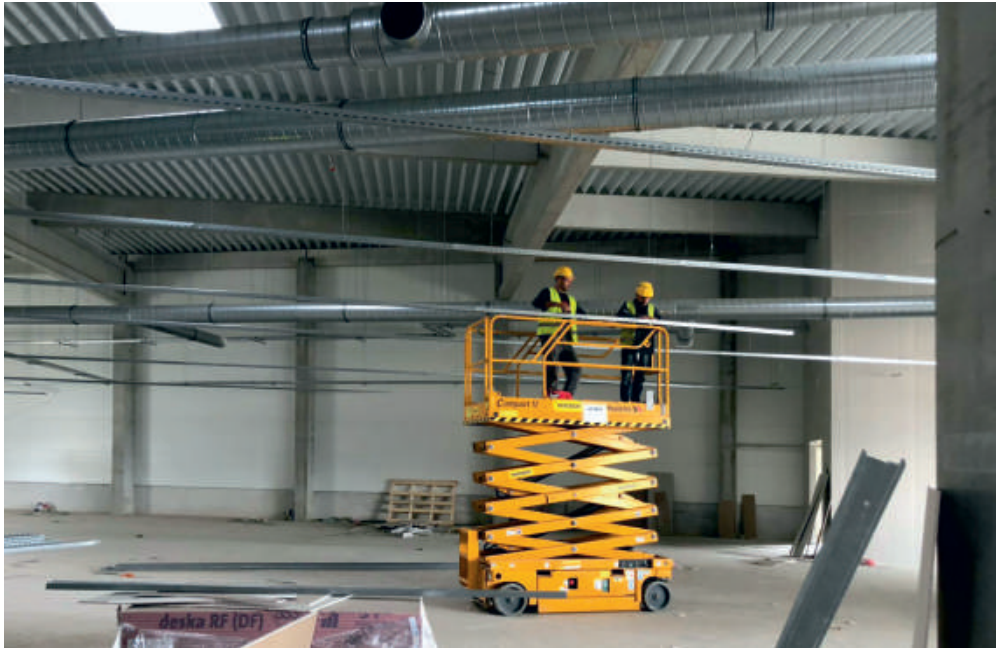
Divize 4 musí montáž vzduchotechniky a dalšího vybavení koordinovat nejen se stavební částí, ale rovněž s nejrůznějšími požadavky jednotlivých obchodních společností.
