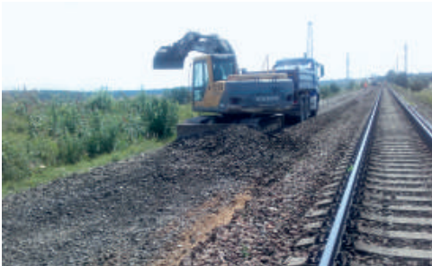
K rekonstrukci železničního spodku patří odtěžení starého šterkového lože.
