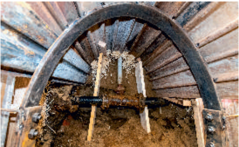
Výměna potrubí často znamená práci ve velice stísněných prostorech.
