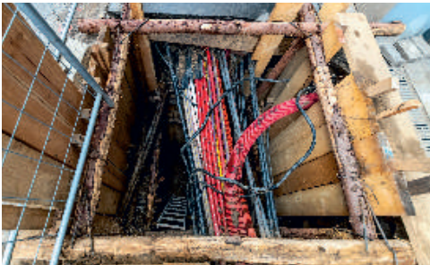
Při rekonstrukci vodovodu v Zenklově ulici se divize 4 musí vypořádat s dalšími sítěmi.
