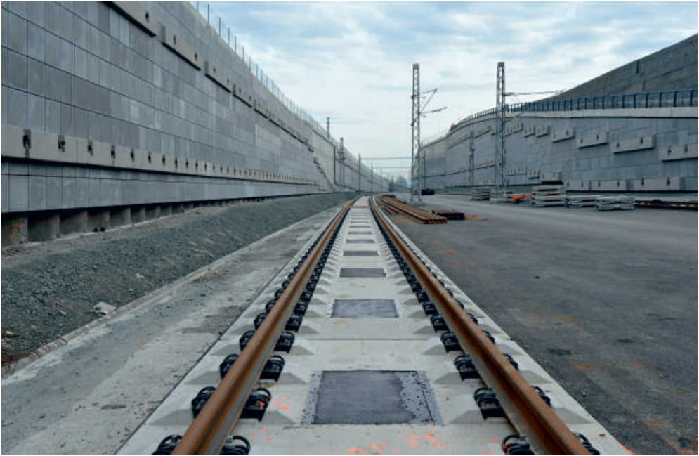
Východní, kyšický portál tunelu Ejpovice ústí do několikasetmetrového hlubokého zářezu, jehož stěny divize 3 pokryla tenkými panely z ultravysokopevnostního betonu.
