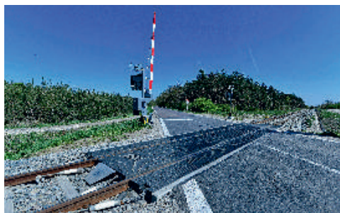
Projekt zahrnoval rovněž rekonstrukci železničních přejezdů.
