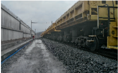
K realizaci šterkového lože před tunelem využila divize 3 také své samovýšpné vozy.
