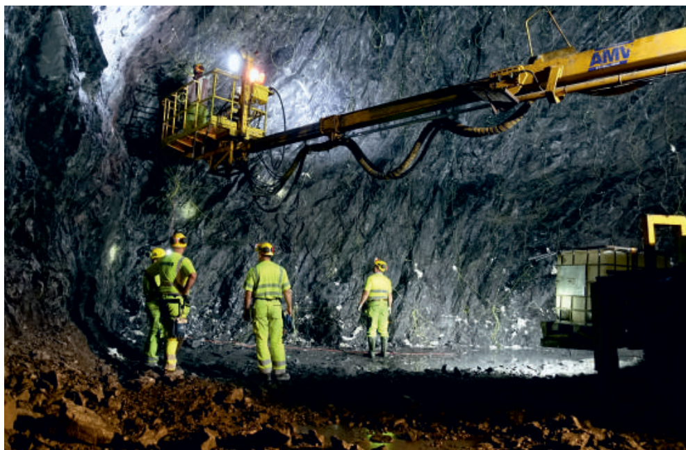
SBT Sverige AB razí dvoutubusový tunel Skärholmen, jenž se nachází v jihozápadní části Stockholmu, skandinávskou metodou. Horninový masiv je rozpojován emulzní trhavinou.
