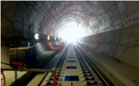
První panely pevné jízdní dráhy byly v květnu položeny v jižním tubusu.
