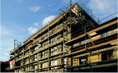
Východní průčelí v ulici Pod Brentovou již pokrývá kontaktní zateplení.
