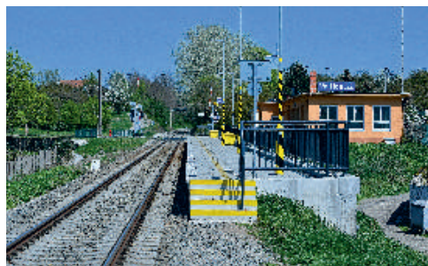
Divize 3 na devítikilometrovém úseku modernizovala i zastávku Valtice město.
