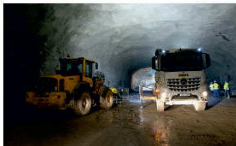
Při práci v podzemí se uplatňují různé druhy stavebních strojů.
