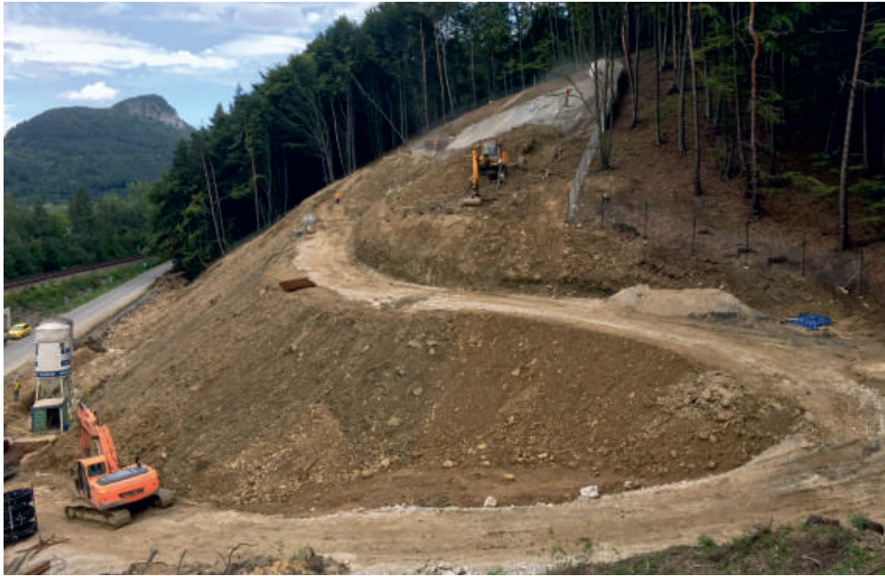
Západní portál železničního tunelu Milochov je budován ve strmém, zalesněném svahu údolí Váhu na úpatí vrchu Stavná.
