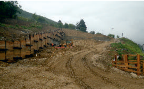
Výstavba v místě východního portálu probíhá v sousedství obytné zástavby.
