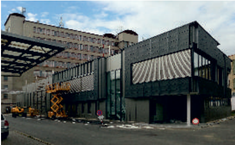
Ocelová stavba je oplášťena sendvičovými fasádními panely a bohatě prosklena.
