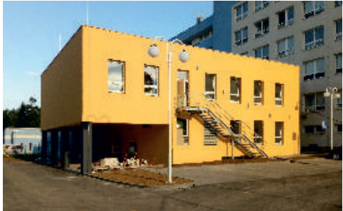
Nová budova skrývá špičkové vybavení, nároky na provedení byly vysoké.
