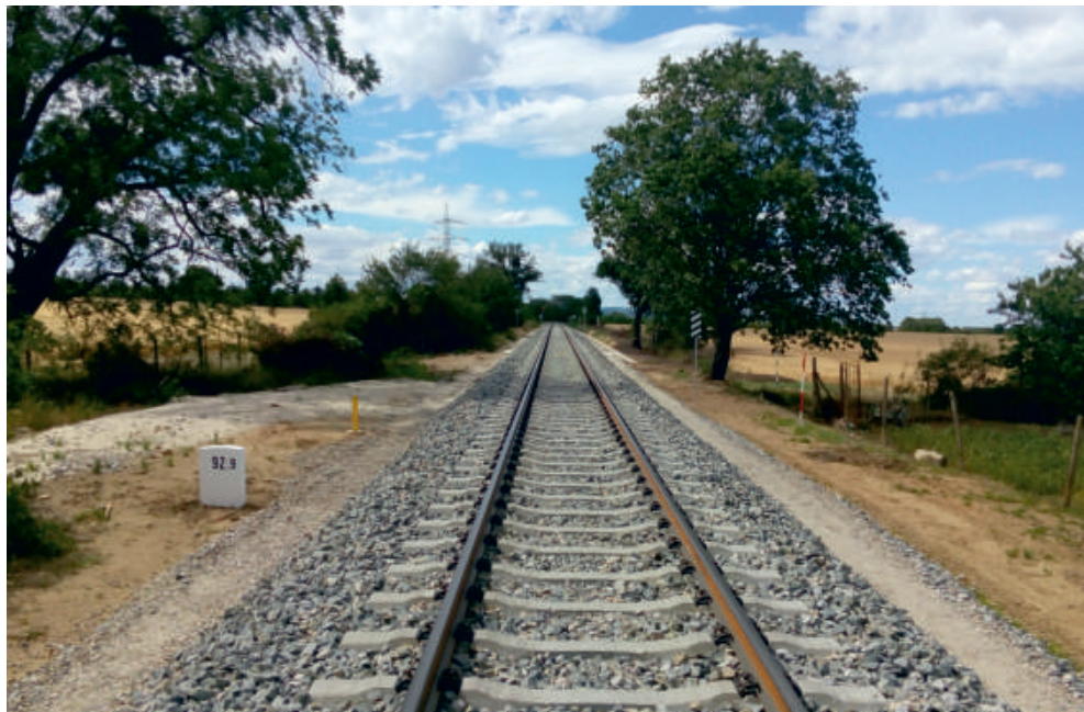
Neelektrifikovaná jednokolejná železniční trať vede jedinečnou krajinou Lednicko-valtického areálu. Práce na její modernější podobě si vyžádaly přibližně půl roku.
