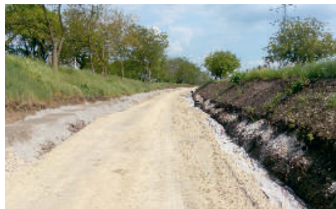
V květnu realizovala divize 3 zejména obnovu železničního spodku.
