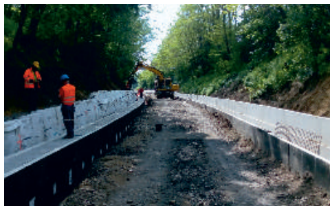
Součástí revitalizace bylo rovněž odvodnění a úprava kabelového vedení.
