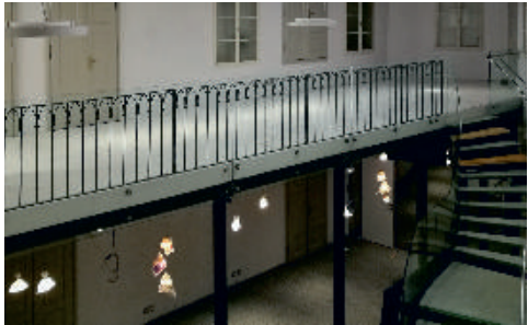
K výrazným prvkům projektu patří schodiště a dekorativní zábradlí.
