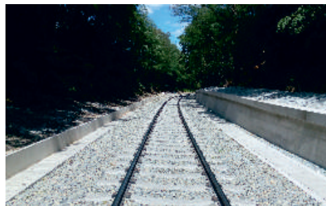
Nové zárubní a opěrné zdi lemuji trať v blízkosti zastávky Valtice město.
