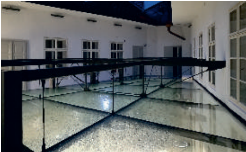
Skleněné zastřešení je zavěšeno na venkovní ocelové konstrukci.
