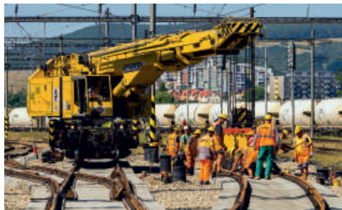
Kolejový jeřáb Kirov KRC 1200 v Berouně posloužil při realizaci výhybek.
