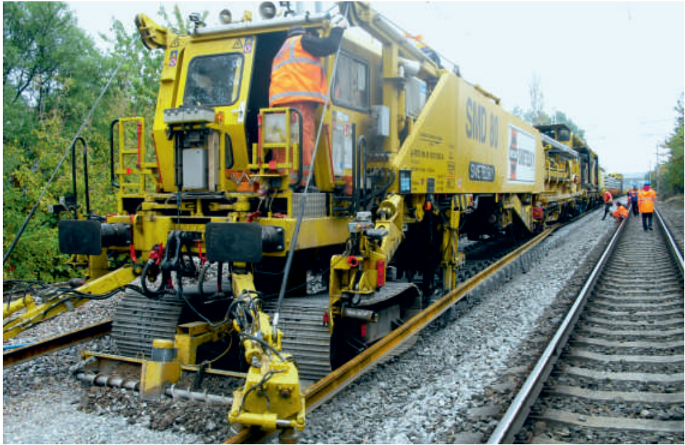
Oddělenou pokládku kolejového svršku na traťovém úseku mezi zastávkou Brno-Černovice a stanicí Brno-Slatina provedla divize 3 s využitím stroje SMD 80.
