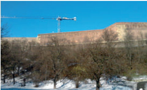
Práce probíhající na severní stěně bastionu již z dálky signalizuje přítomnost jeřábu.
