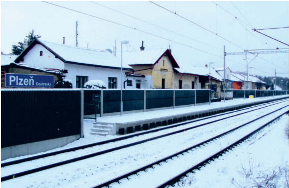
Po léta zanedbaná zastávka Plzeň-Doubravka se výrazně proměnila. Kromě protihlukových stěn přibýlo také 170metrové nástupiště, osvětlení a bezbariérové úpravy.
