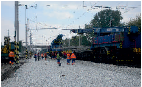
Nová kolejová pole na brněnské stavbě Černovice–Slatina pokládal stroj EDK.
