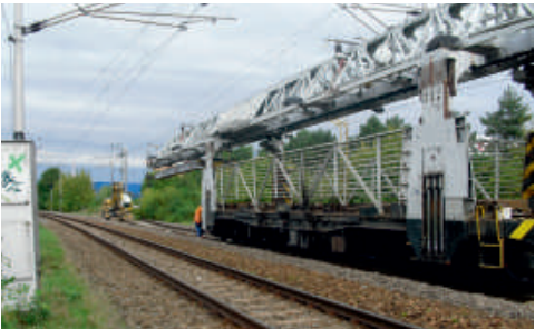
Trhání kolejových polí na trati mezi Blažovicemi a Nesovicemi zajišťoval stroj UK.
