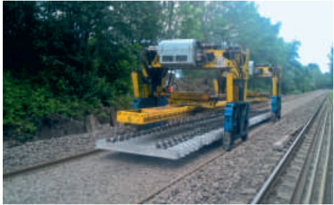
Ke zřízení kolejového roštu posloužil pokladač pražců PTH 350.
