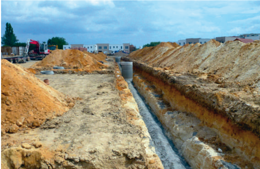
Výstavba čtyř desítek letňanských domů se po více než roce dostala do své závěrečné fáze, s přípravou inženýrských sítí pro další etapu je Subterra zhruba v polovině.
