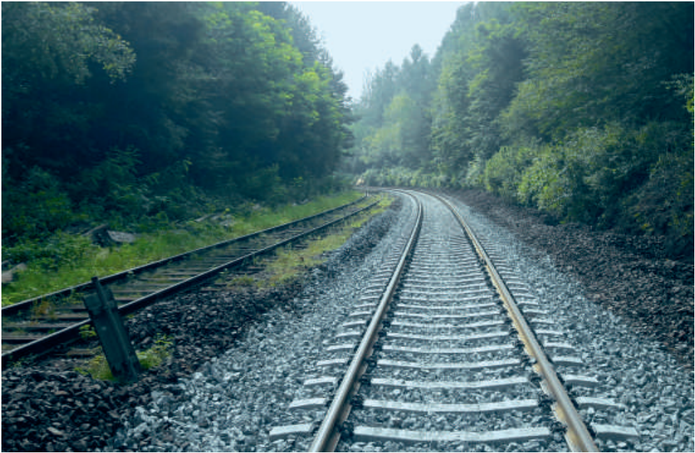
Neelektrifikovaná regionální trať spojující Kladno a Rakovník byla modernizována v několika částech úseku Stochov–Řevničov. Celková délka nových kolejí přesahuje pět kilometrů.
