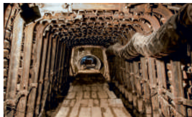
KANALIZACE V ULICI POD ALTÁNEM
