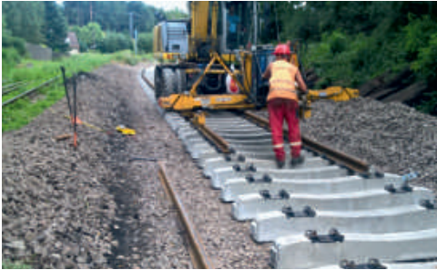
Na rekonstrukci jednokolejné trati bylo třeba nasadit dvoucestné bagry.
