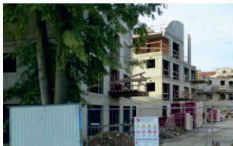
Po betonáži nosných stěn již Corso Pod Lipami získalo svoji charakteristickou siluetu.
