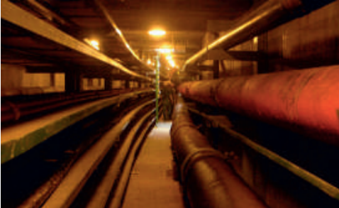
Nová trasa propojí stávající vedení, na levém břehu naváže na kolektor SPHM.
