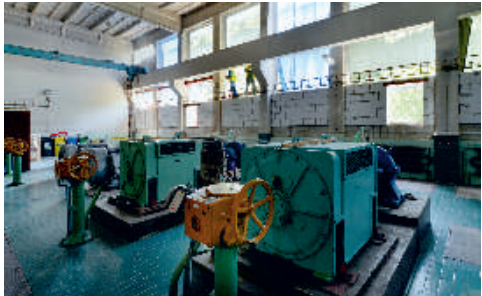
Divize 4 již provádí stavební úpravy v hale, do níž poté nainstaluje nová čerpadla.
