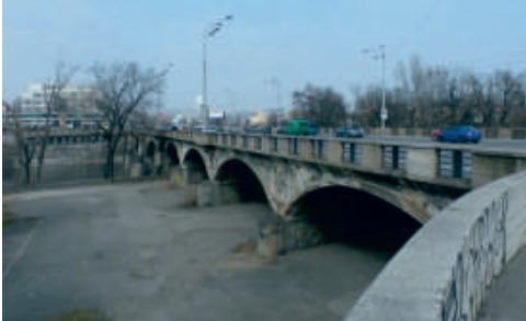
Přeložení sítí do kolektoru umožní přistoupit k rekonstrukci Hlávkova mostu.
