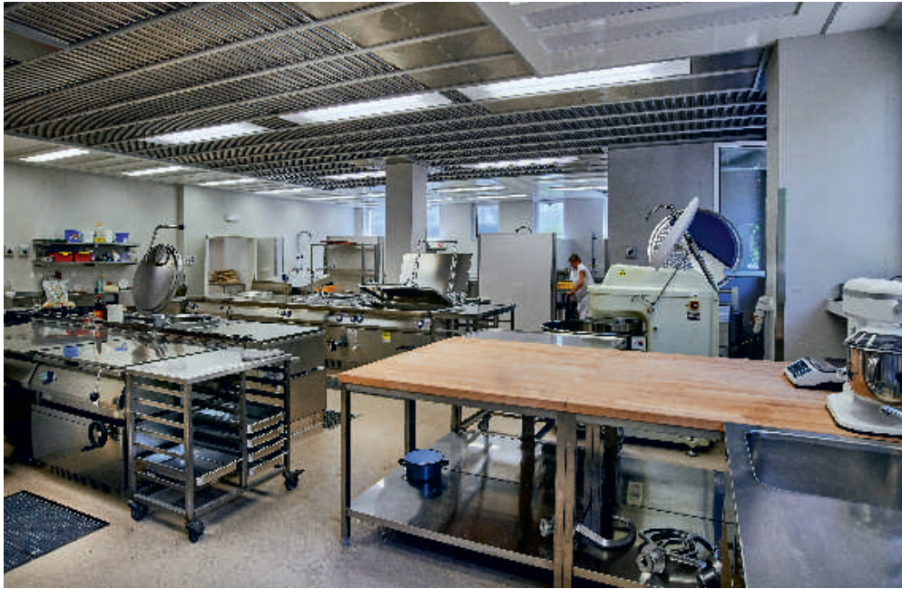
Kuchyně ZŠ Filosofská získala novou podobu, ke které kromě vlastních gastrotechnologií přispívají především moderní instalace včetně vzduchotechnických stropů.
