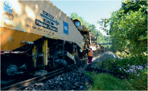
Stroj 60metrové délky dokáže okamžitě vyměnit pražce i bez snesení kolejí.
