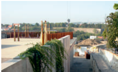
OPRAVA BASTIONU U BOŽÍCH MUK
