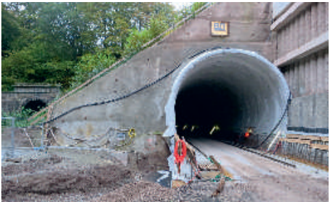
Vlevo od východního portálu tunelu Zierenberg se nachází jeho předchůdce.
