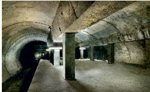
Nádraží Veleslavín je dosud jedinou pražskou trojpodlažní stanicí raženou NRTM.
