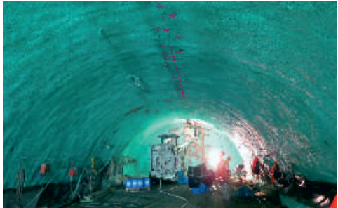
Ražba tramvajového tunelu v Karlsruhe probíhá v kesonu, přetlak pro kalotu je 0,9 baru.
