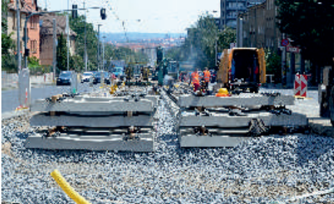
Při rekonstrukci tramvajové trati na Evropské byl zcela nahrazen její spodek i svršek.
