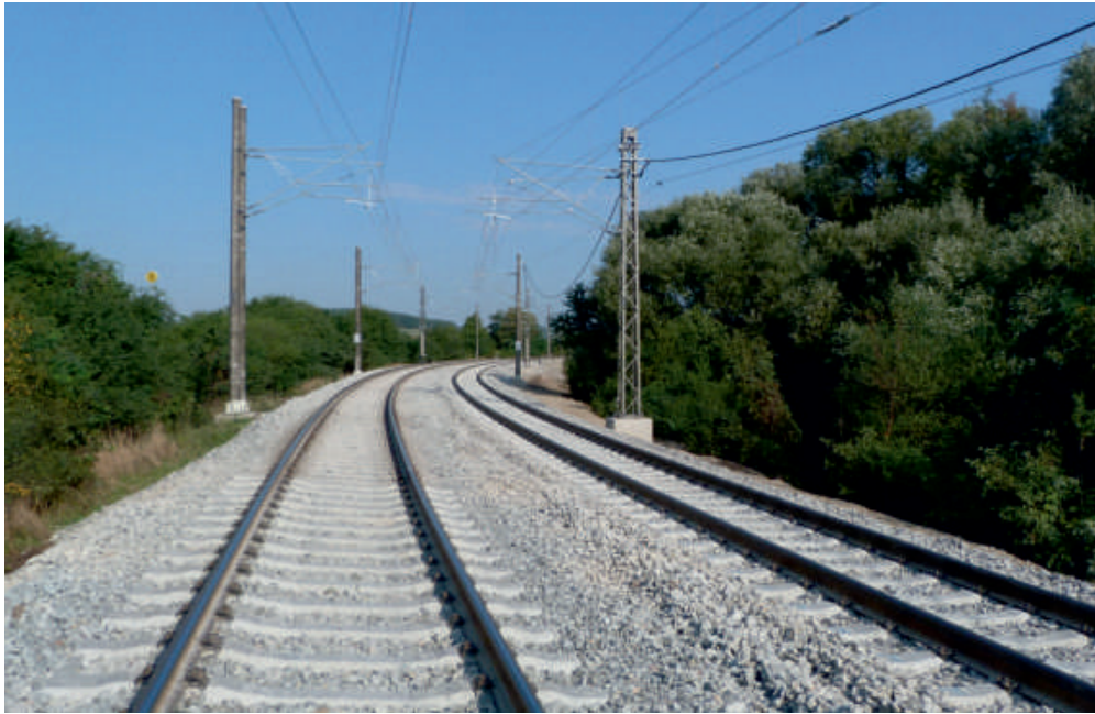
Ukončení rekonstrukce traťové koleje č. 2 završilo modernizaci celého úseku. Kromě rychlejšího cestování mezi Brnem a Kuřimi přináší projekt také snížení hluku v okolí železnice.
