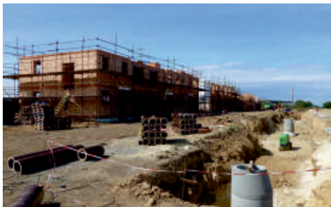
Spolu s realizací inženýrských sítí na místě již probíhá i stavba řadových domů.
