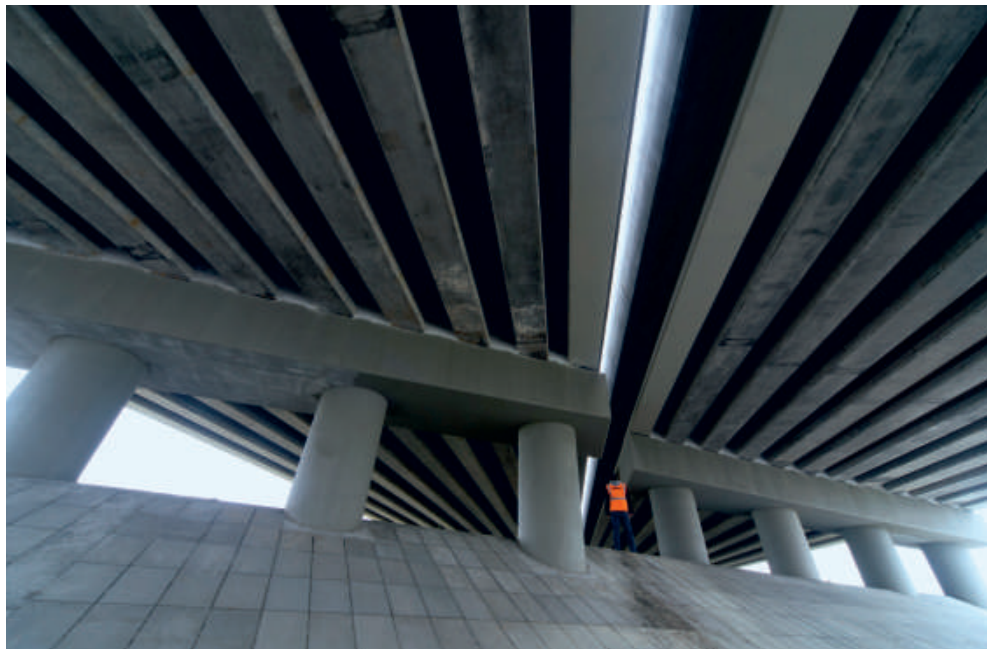
Konstrukce většiny mostů na posledním úseku dálnice M43 je tvořena montovanými nosníky z předpjatého železobetonu, s nimiž staticky spolupůsobí monolitická deska.
