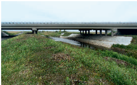
Všem ostatním stavbám se vymyká 120metrové přemostění potoka o třech polích.
