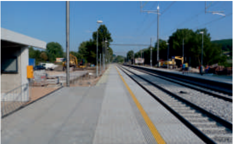
Součástí rekonstrukce byla též úprava brněnských zastávek Česká a Řečkovice.
