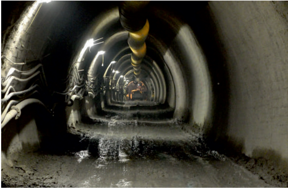
Průzkumná štola o průřezu přesahujícím 13 metrů čtverečných sleduje budoucí trasu tunelu Radlice. Divize 1 prováděla ražbu více než jeden rok.
