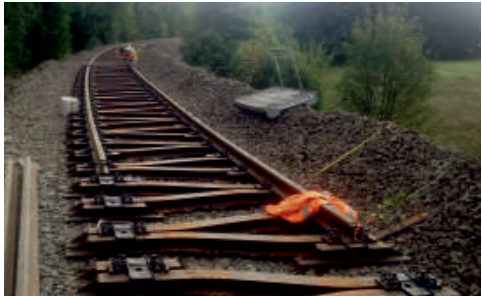
Ocelové pražce ve tvaru Y jsou prostorově méně náročné než běžné betonové.
