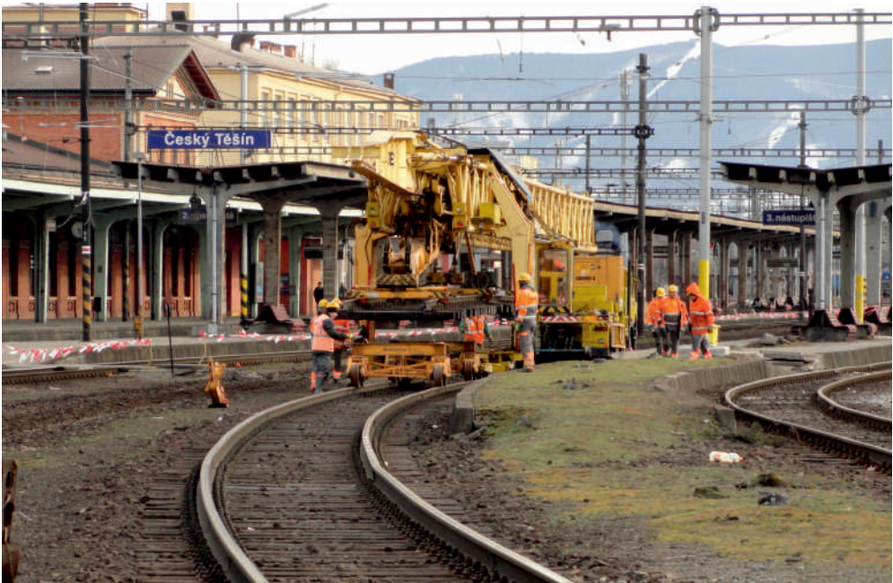
Rekonstrukce těšínského osobního nádraží zahrnuje opravu nástupišť i výměnu traťového svršku. Původní koleje na dřevěných pražcích jsou postupně snášeny a nahrazovány.
