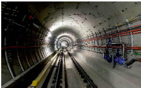
Divize 4 realizovala na nové trase značnou část kabelových rozvodů a osvětlení traťových tunelů.
