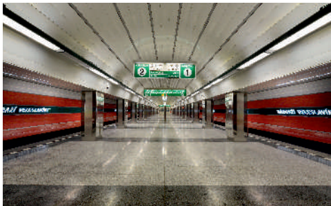
Trojloďní stanici razila divize 1 Novou rakouskou tunelovací metodou, poprvé v Praze.
