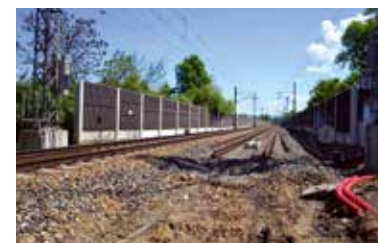
MODERNIZACE TRATI ROKYCANY – PLZEŇ
