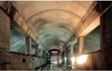
BETONÁŽE V RAŽENÉ ČÁSTI STANICE VELESLAVÍN SKONČILY
