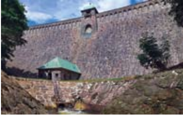
STABILITA VODNÍHO DÍLA JANOV JE ZAJIŠTĚNA INJEKČNÍ CLONOU
