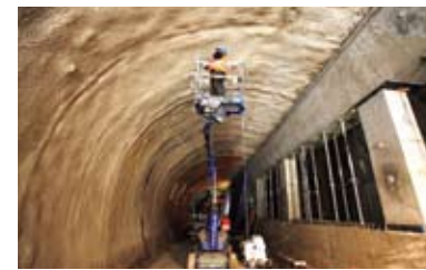
STŘÍKANÁ HYDROIZOLACE VE STANICI VELESLAVÍN
