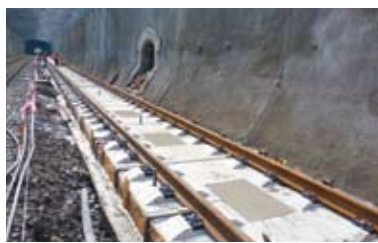
TUNEL S PEVNOU JÍZDNÍ DRÁHOU
