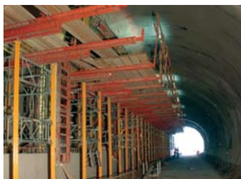
Bednění sloupů a trámu v délce dilatace 36 metrů
