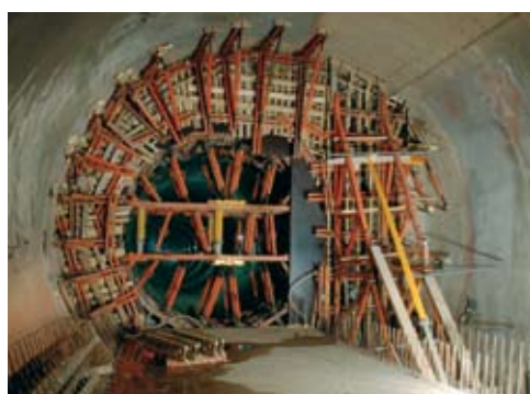
Bednění přechodové stěny mezi profilem NRTM a TBM
