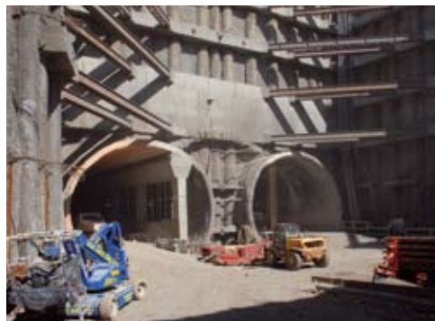
Portálová stěna trojlodní stanice Veleslavín
