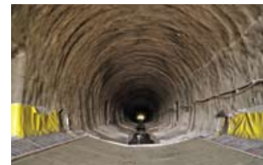
TUNEL V MOSTECH U JABLUNKOVA JE VYRAŽEN
