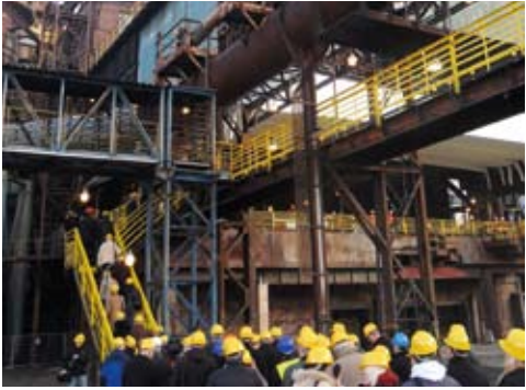
Přístup do nově zrekonstruované Vysoké pece číslo 1
