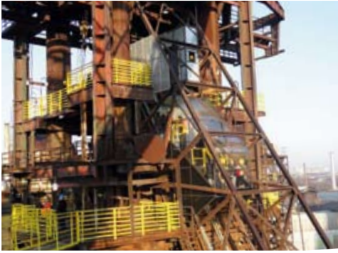
Prosklený skipový výtah vyvezl první návštěvníky
