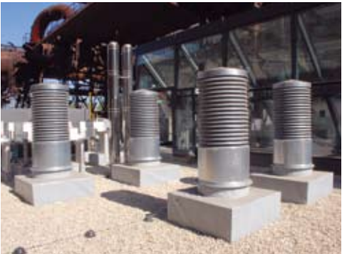
Střešní skladba energocentra s výdechy a nasáváním vzduchotechniky
