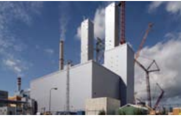
NA DOSTAVBĚ ELEKTRÁRNY LEDVICE SE PODÍLÍ DIVIZE 4
