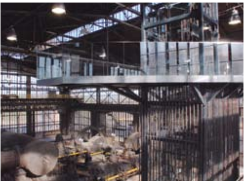
Výhledová věž s výtahem dominuje objektu VI. energetické ústředny
