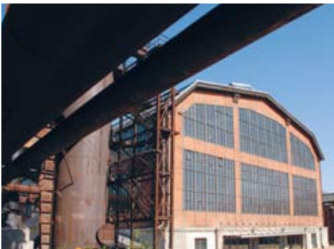
Dokončená západní fasáda VI. energetické ústředny věrně kopíruje původní industriální vzhled
