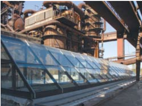
Proskleným světlíkem lze v rámci exkurzí nahlížet do vybavení nového energocentra
