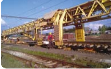
BILANCE PRACÍ NA TRATI ZBIROH–ROKYCANY
