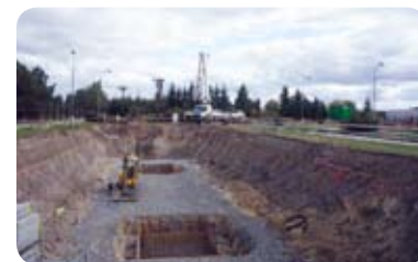
REKONSTRUKCE ČOV V ŠESTAJOVICÍCH ZAČALA
