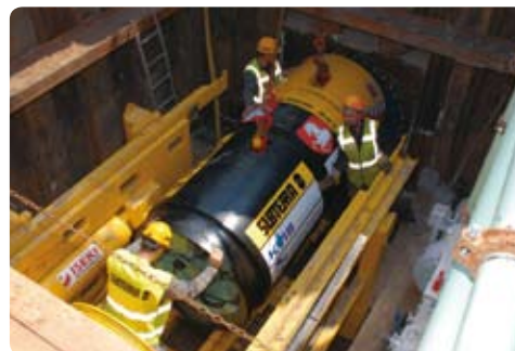
Pracovní tým divize 1 usazuje stroj do připravené rozrážky, odkud bude vyraženo téměř 150 metrů
