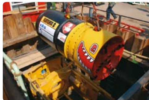
Spouštění mikrotunelovacího stroje ISEKI o průměru 1300 milimetrů do startovací jámy
