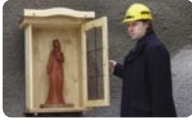
RAŽBA ZAHRADNICKÉHO TUNELU ZAHÁJENA
